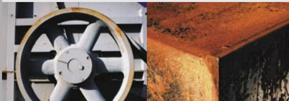
**A5** **ржавая металлическая поверхность.** Объекты, с которых невозможно полностью удалить ржавчину и остатки краски. Краску следует наносить на прочную старую окраску и ржавчину (после удаления шелущающейся краски и ржавчины)
